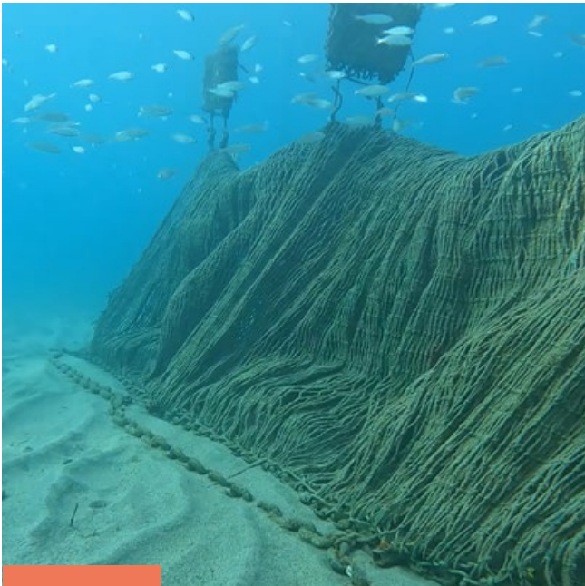
Atténuateur de houle au large de Vias (34) - Source : Seaneo
