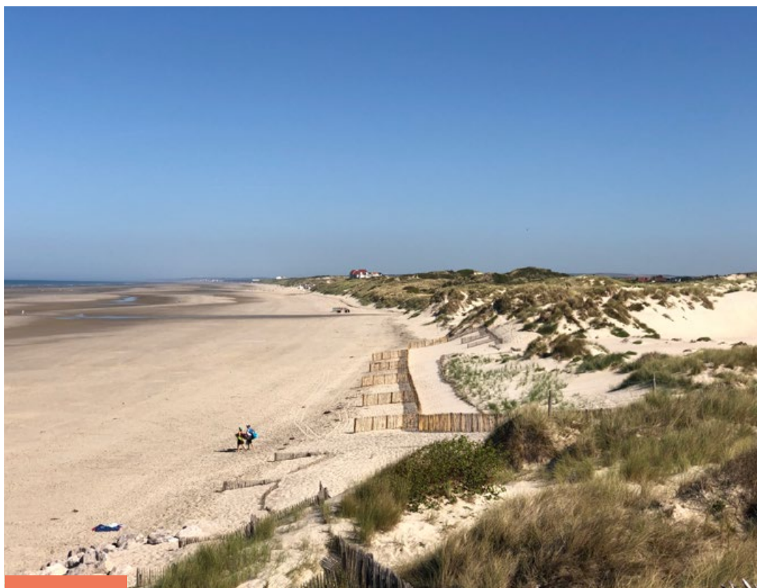
Des solutions fondées sur la nature mises en place par le service Gemapi-e de la CA2BM : installation de ganivelles et plantation d'oyats sur le massif dunaire au nord de Merlimont (62) - Source : service Gemapi-e de la CA2BM
