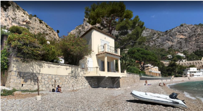
Figure 5 : Bâtiment atteint par le tampon, mais retiré en raison d'un mur de soutènement « protégeant » le bâti (Source de l'image : Google Maps)
